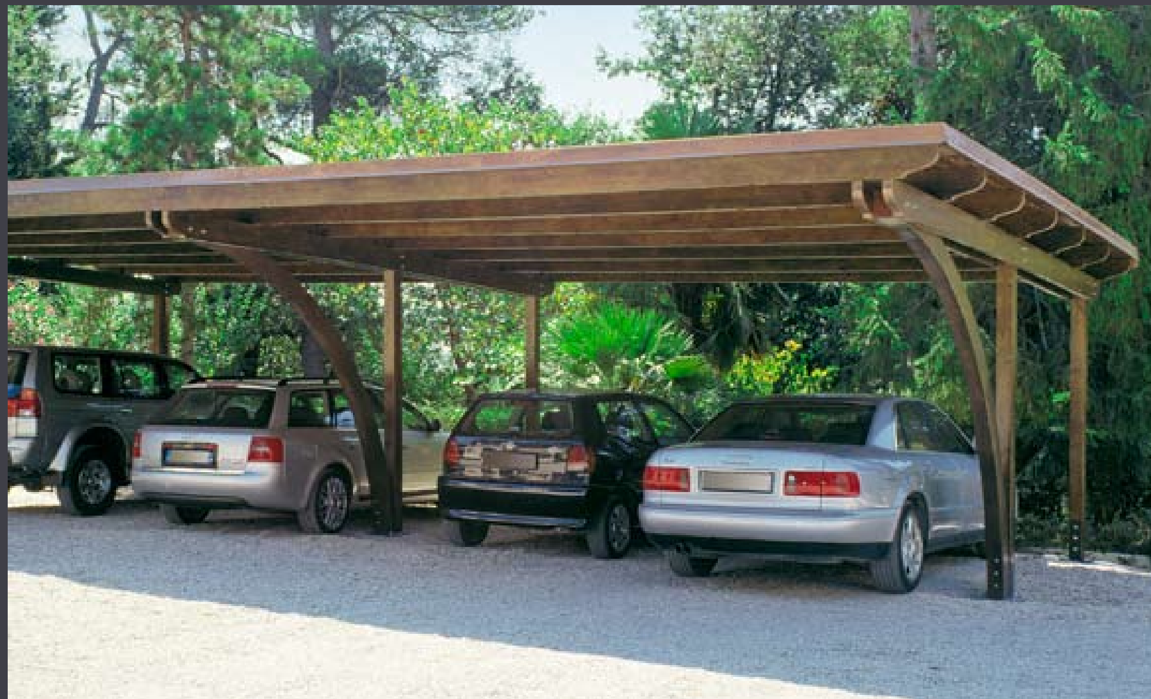
Carport maxi mod. Detroit da quattro posti auto con copertura in perlinato e tegola canadese
