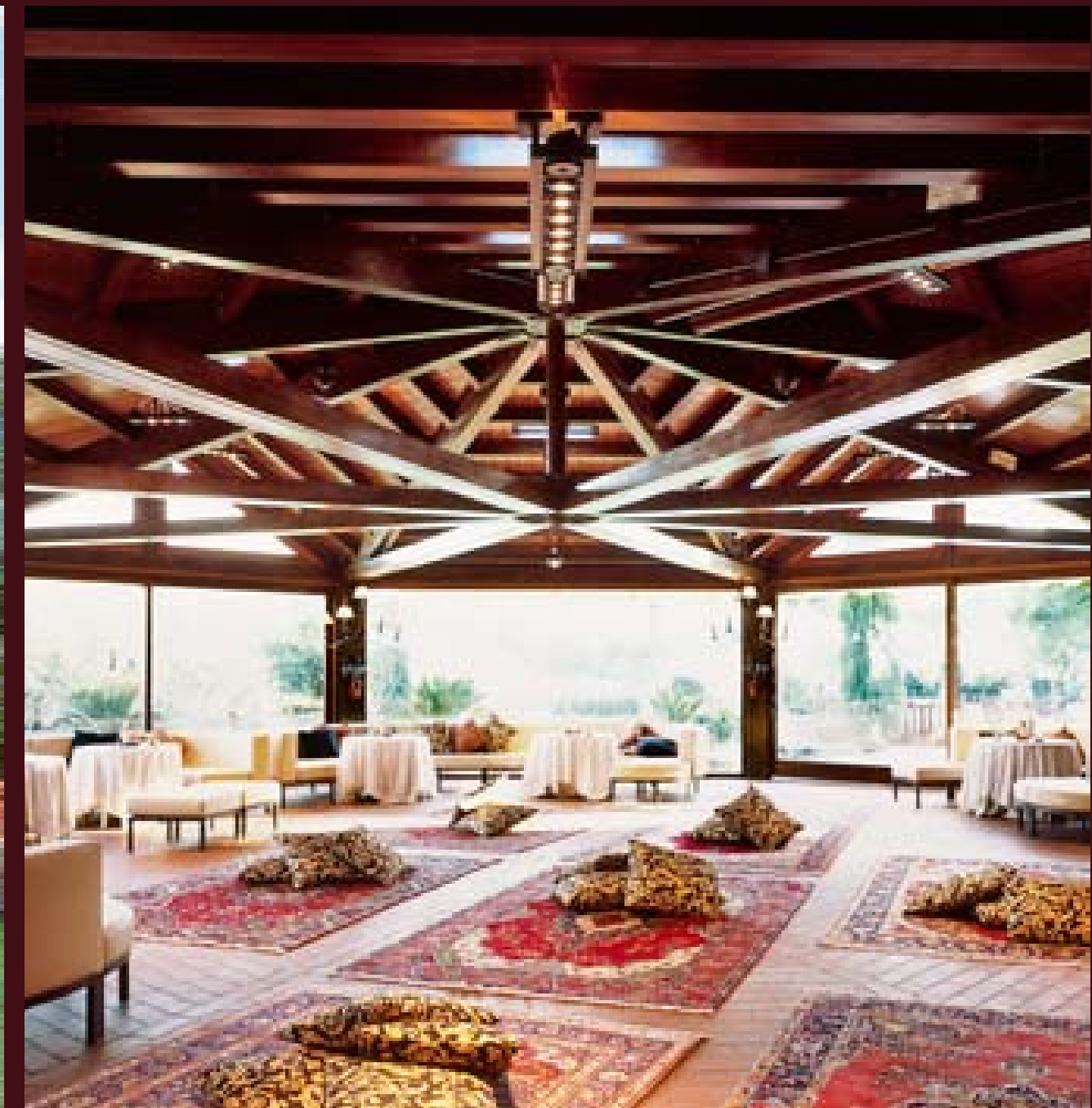
Struttura a pianta ottagonale con n° 4 abbaini e copertura in tegola ramata, superficie m 2 300 e vista interna
