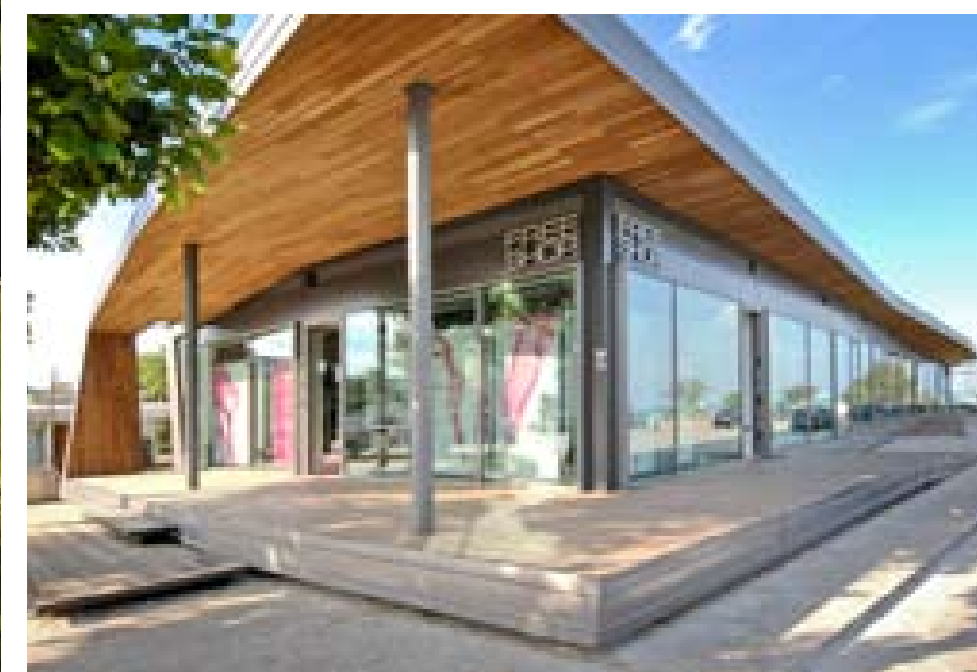
Costruzione commerciale mista acciaio - legno da m 2 700, rivestimento interno in legno e vista esterna
