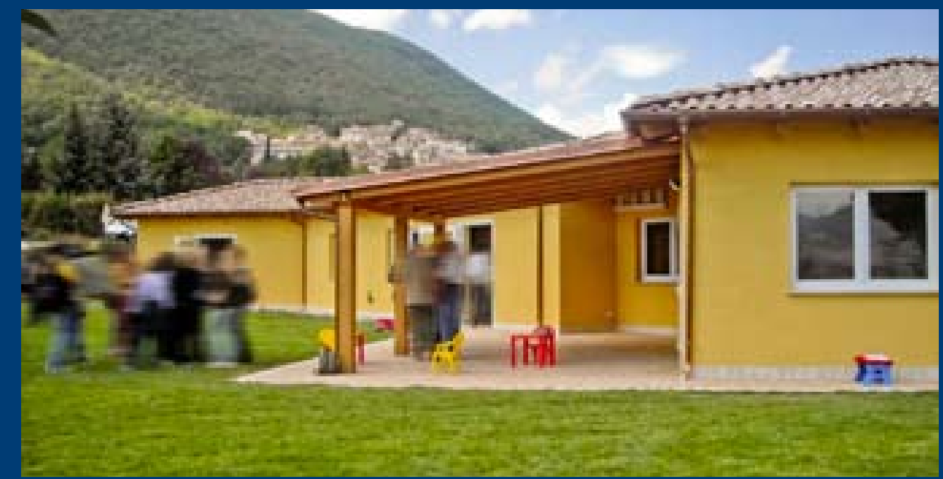
Asilo antisismico in bioedilizia da m 2 220 realizzato a Villa Sant'Angelo (AQ) in 60 giorni, prima realizzazione del suo genere dopo il sisma
