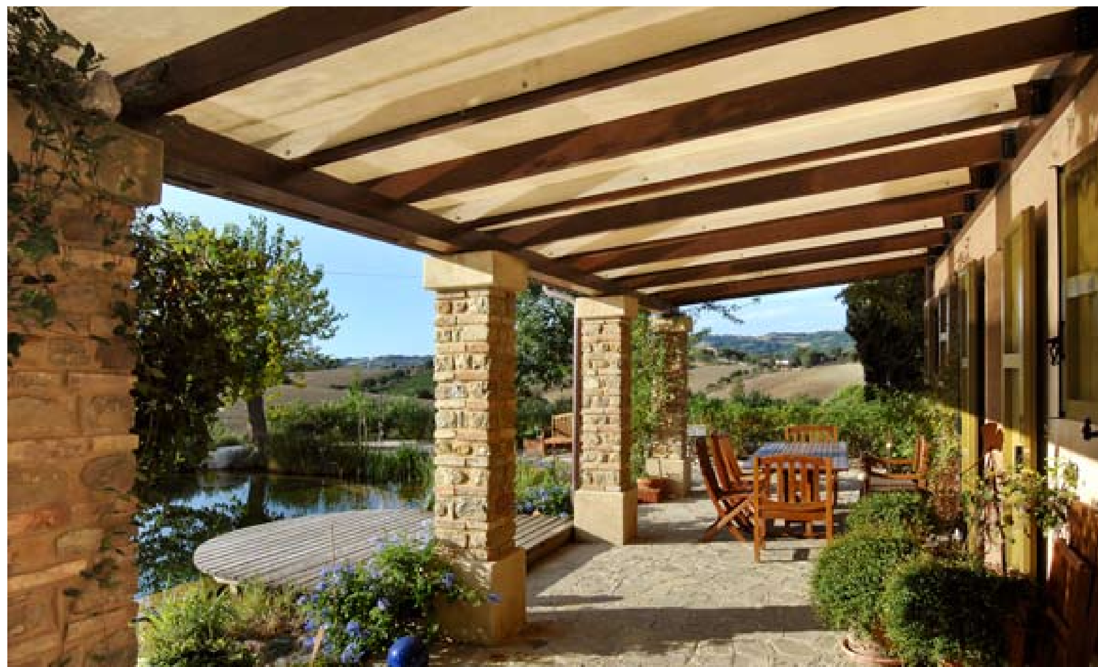
Pergola da m 2 50 con copertura in telo PVC unico vista esterna e vista interna
