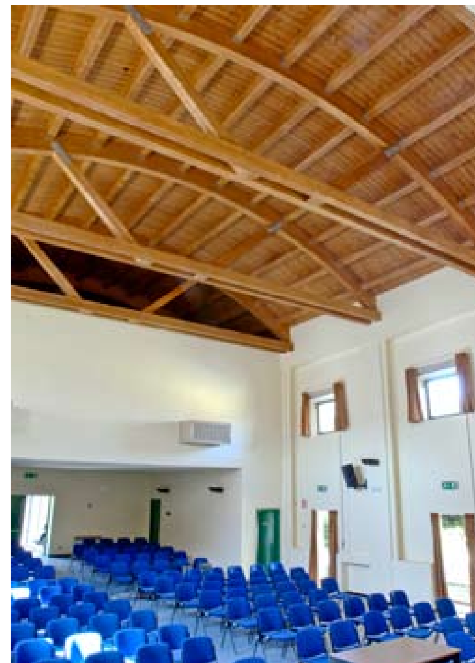
Copertura sala polifunzionale con travi lamellari curve
