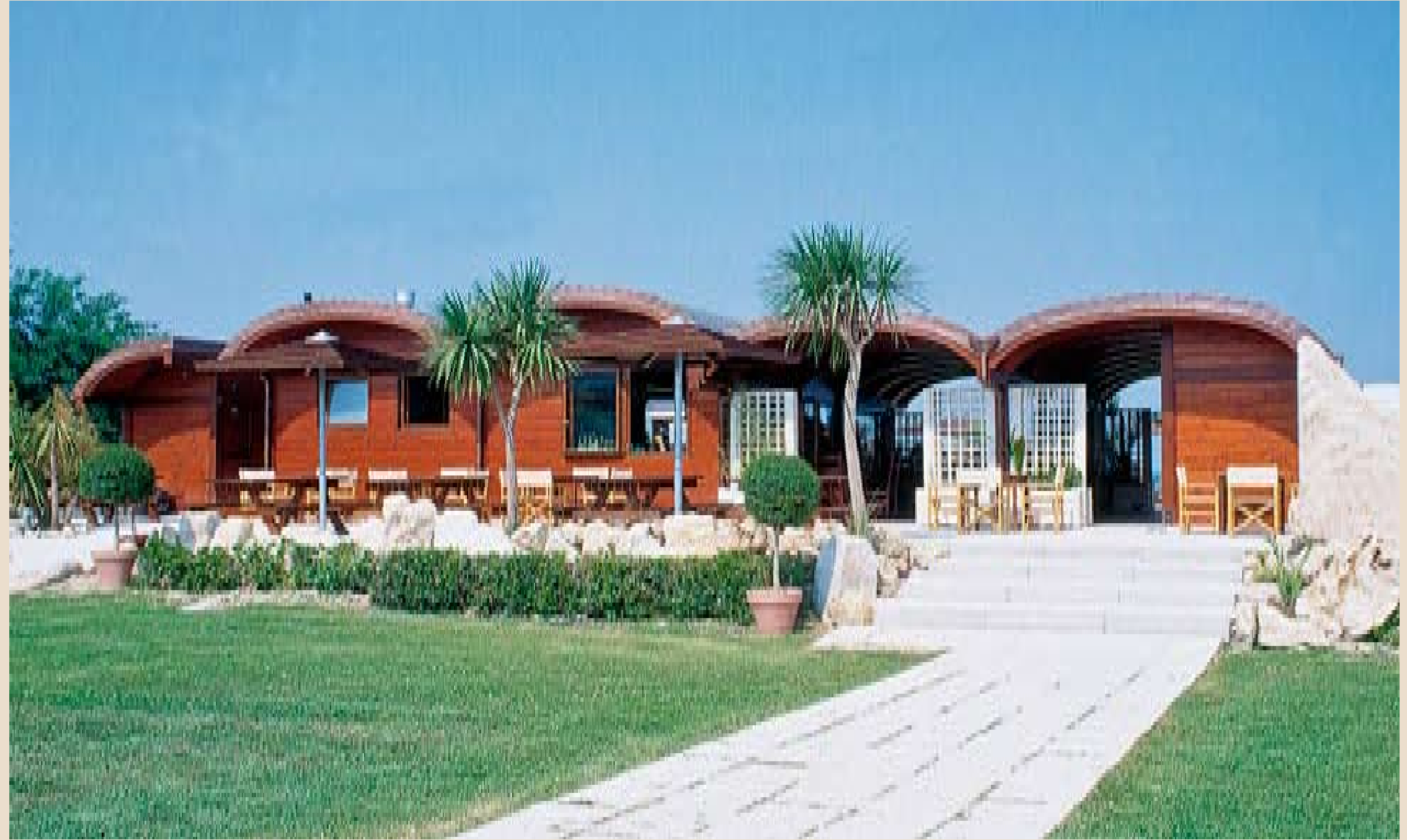
Struttura con copertura a volta da m 2 250
