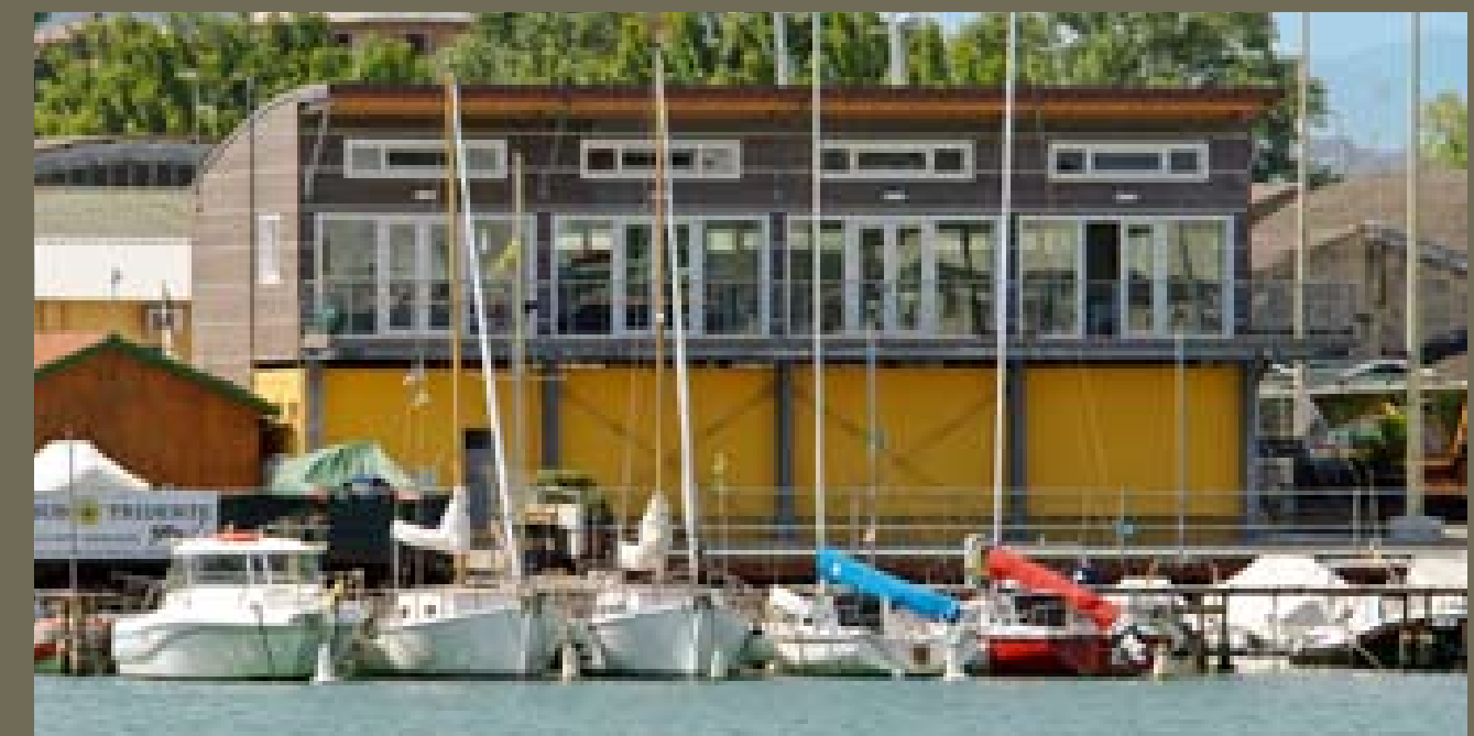
Sopraelevazione con struttura mista acciaio - legno da m 2 150, vista interna e vista esterna
