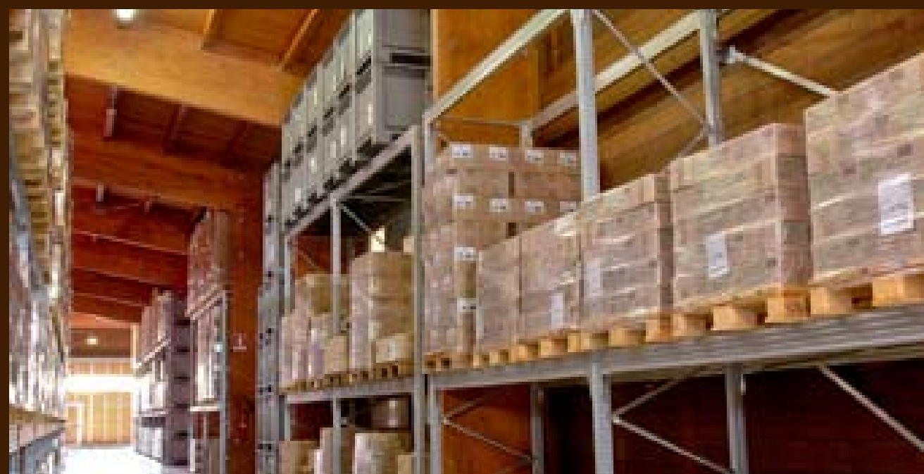
Fabbricato in bioedilizia da m 2 1200 luce libera m 16,00, vista esterna e vista interna
