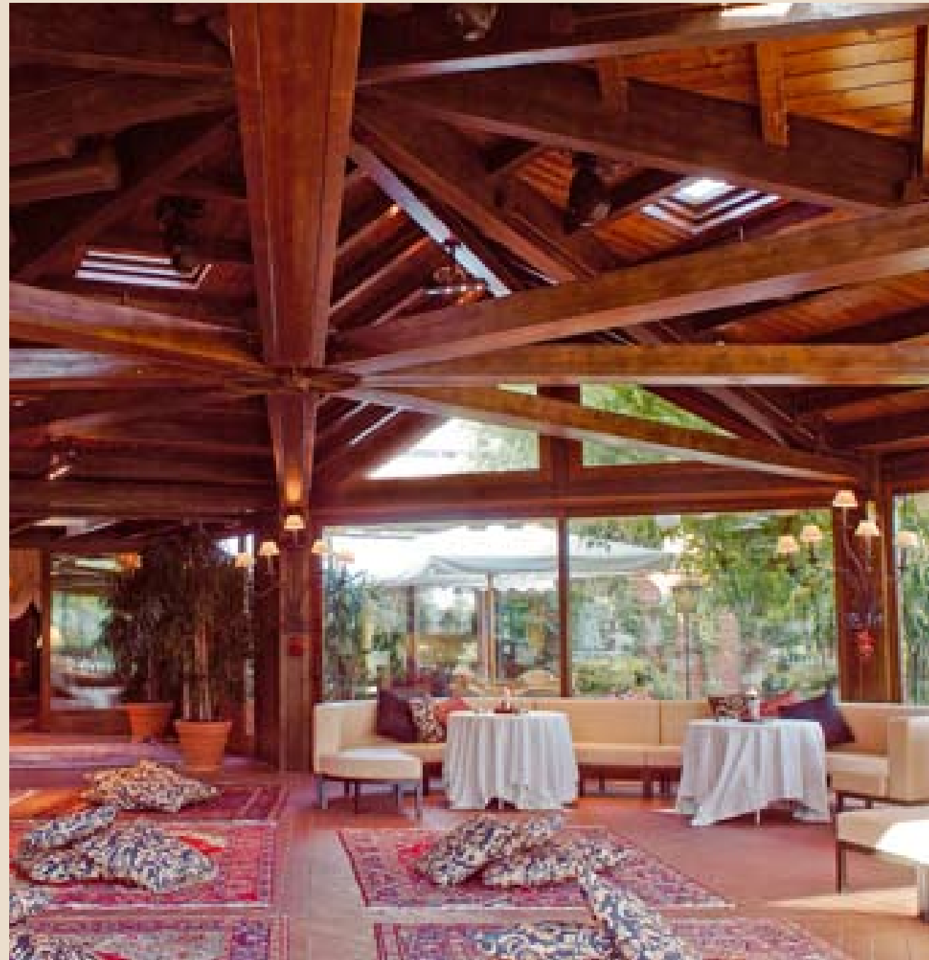
Struttura a pianta ottagonale particolare nodo centrale e tirante in legno
