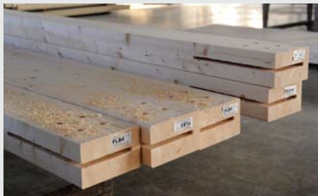
3.1 Fresatura per alloggiamento piastra Spinotto su travi lamellari
