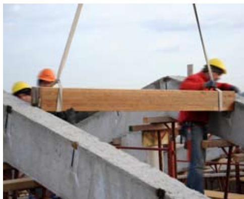
4.1 Posizionamento della trave in legno
