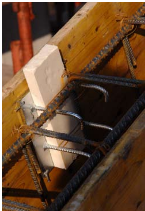
1.1 Posizionamento della piastra Coulisse prima del getto
