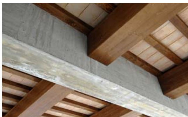
5.3 Completamento del solaio
