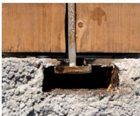
4.3 Vista dall'alto della piastra inserita regolarmente
